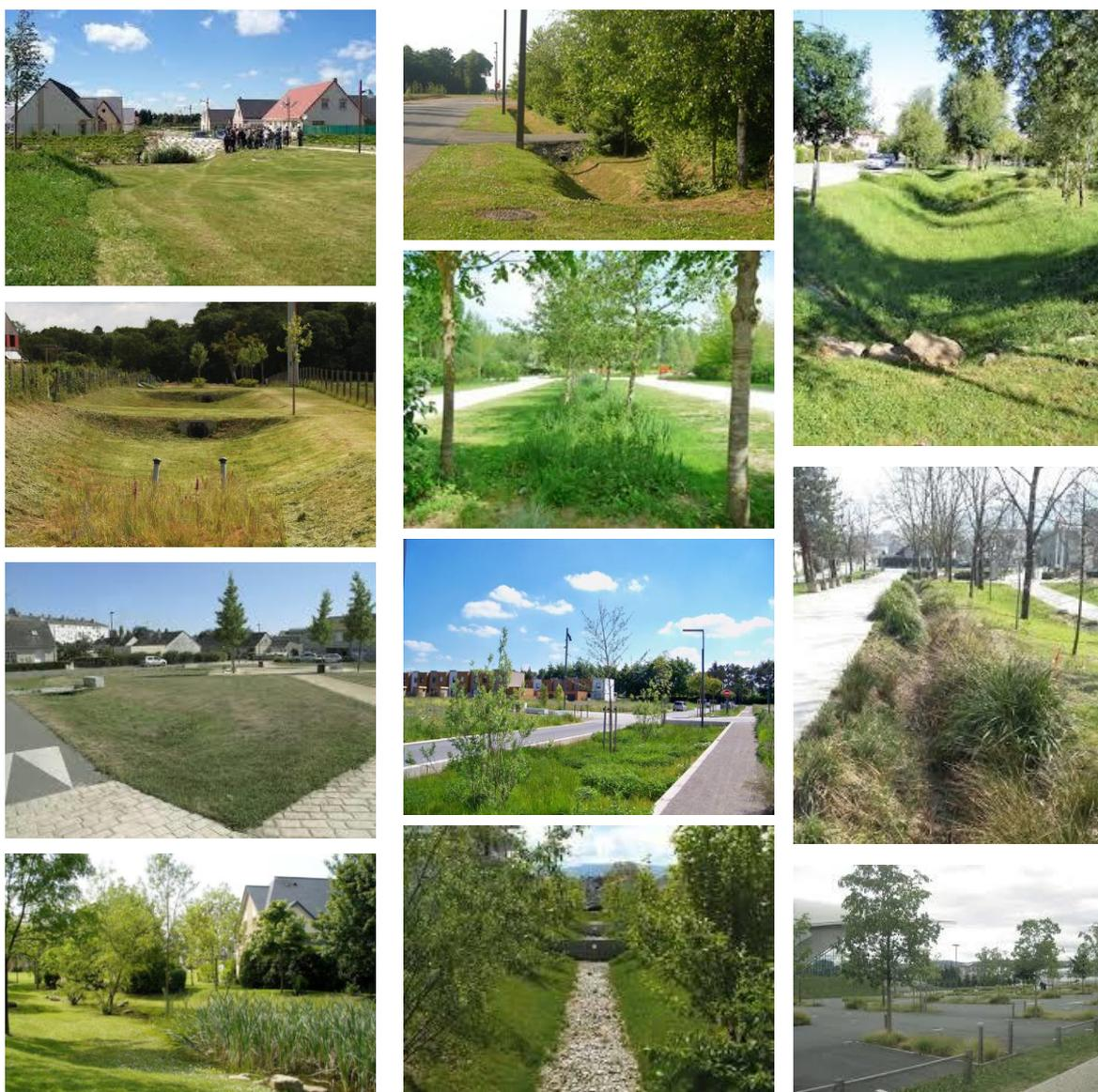
**Fig. 3. Exemples de noues et de bassins pour la gestion des eaux pluviales**
